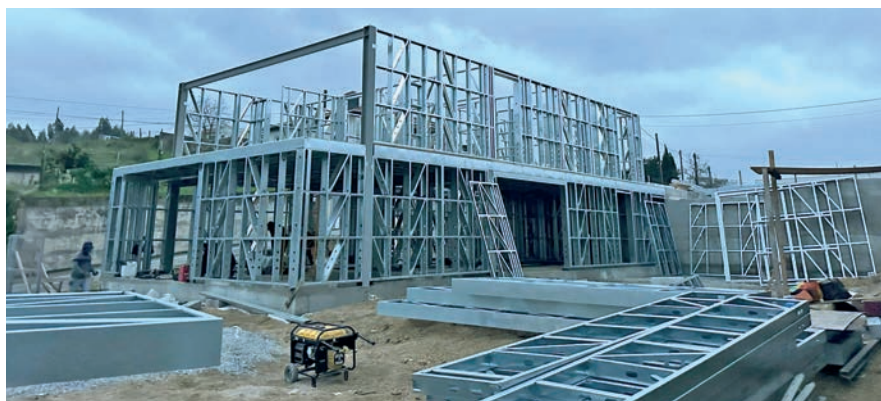
▲ Nuevo sistema constructivo Steel Frame, una tecnología que permite crear estructuras ligeras, resistentes y duraderas, con una gran flexibilidad de diseño.
