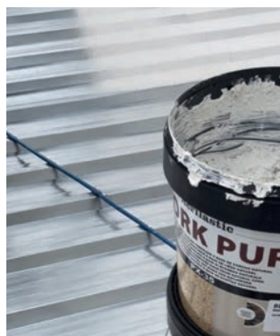
▲ Aplicación RX-35 sobre placa acero galvanizado.
