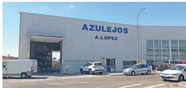
▲ Instalaciones de A. López Dos, S.L.,
