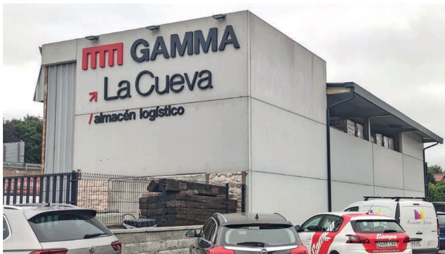
▲ Instalaciones de GAMMA La Cueva en la localidad asturiana de Muros de Nalón.
