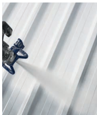
▲ Aplicación RX-37 sobre placa acero galvanizado.
