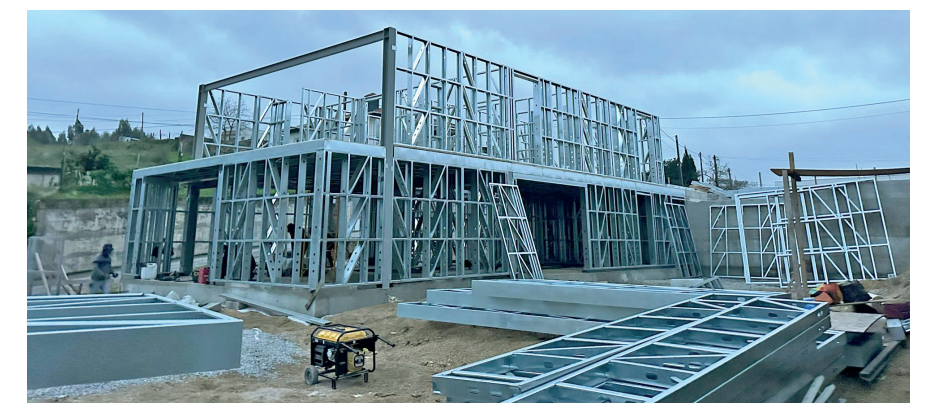
▲ Nuevo sistema constructivo Steel Frame, una tecnología que permite crear estructuras ligeras, resistentes y duraderas, con una gran flexibilidad de diseño.
