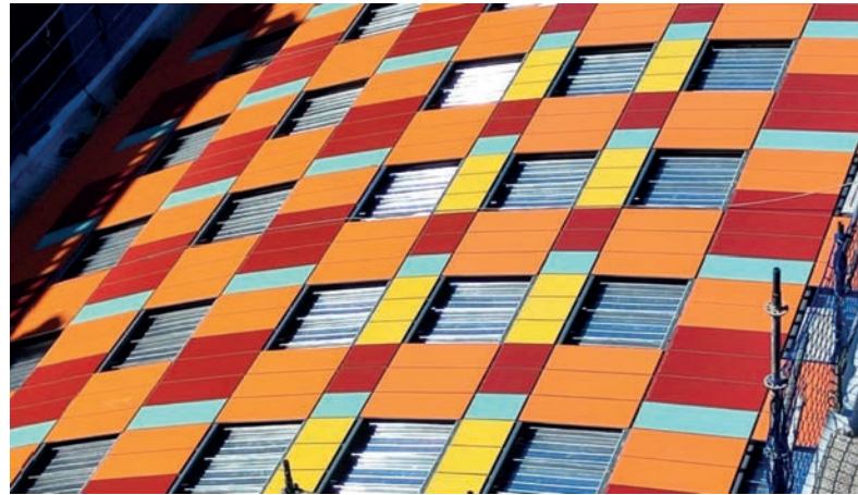
▲ Detalle de las piezas y el sistema de cubierta ventilada Frontek.
