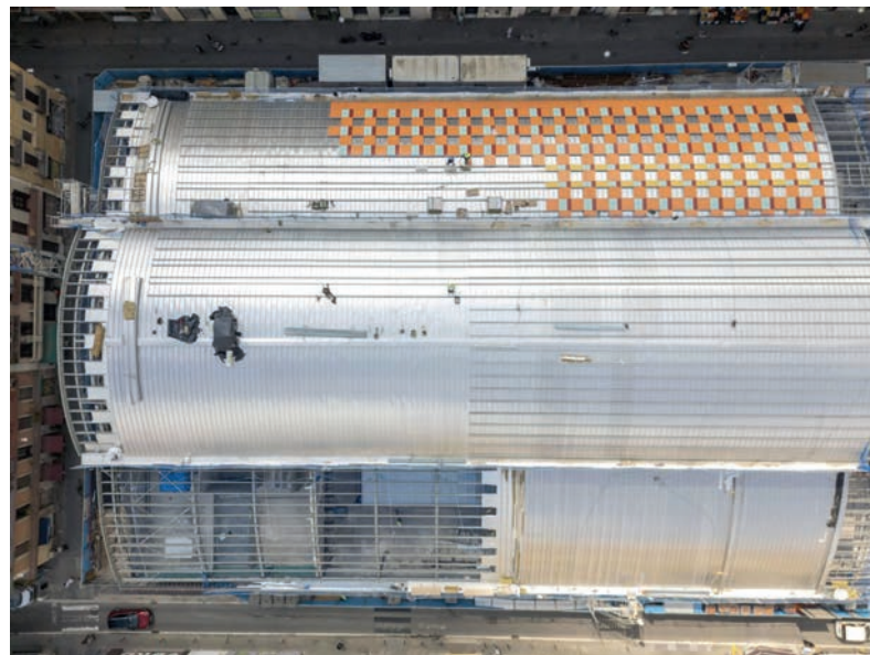
▲ Diferencia evidente entre la cubierta antigua y la nueva de Frontek.
