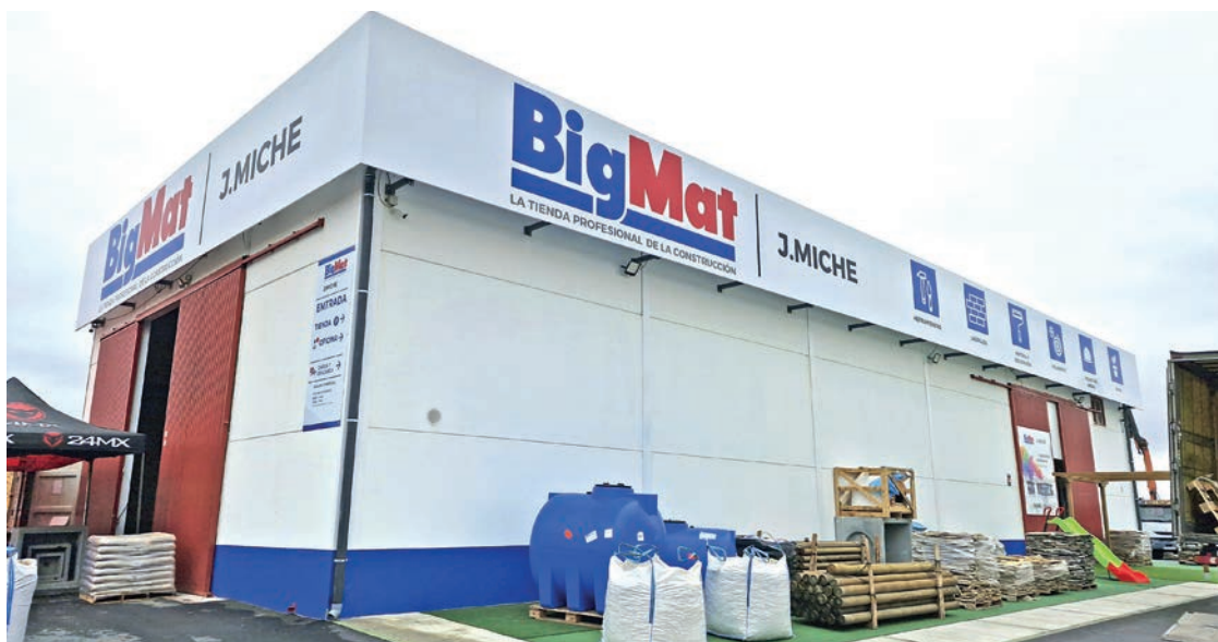
◀ Instalaciones de BigMat J Miche en la localidad de Gibraleón (Huelva)
