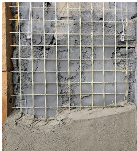
◀ Malla MESH colocada en obra.
